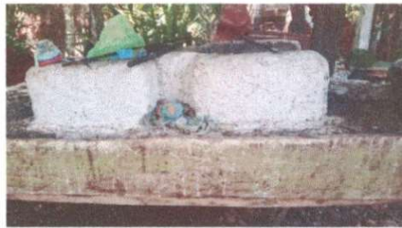
Foto 6: Mantenimiento a estufa rural
