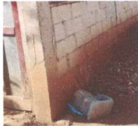
Foto 9: Pintura en muros exteriores e interiores
