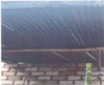
Foto1: Sustitución de lamina, por lamina troquelada aluzinc calibre 26 en cocina
