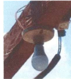
Foto 10: Instalación de unidades de luz y fuerza (incluye interruptor, plafonera, foco, tomacorriente, ducto y cable eléctrico)
