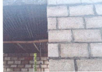
Foto 8: Repello en muro y pared
