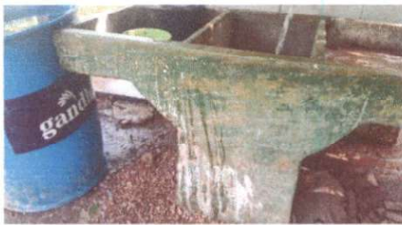
Foto 11: Sustitución de pila de cemento de dos lavadero
