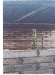
Foto 2: Sustitución de estructura de soporte de madera por metal
