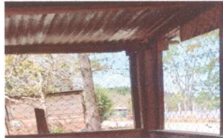
Foto 4: Sustitución de balcones de metal
