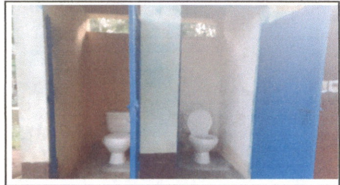
Foto 4: INSTALACION BAÑOS LAVABLES
