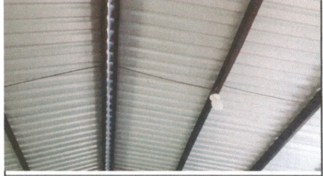
Foto 2: INSTALACION DE LAMINA POR LAMINA GALVANIZADA ALUZIN
