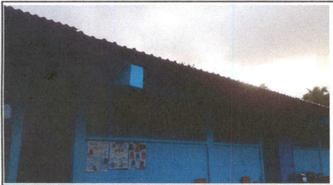
Foto 3: INSTALACION DE BALCONES DE VENTANA
