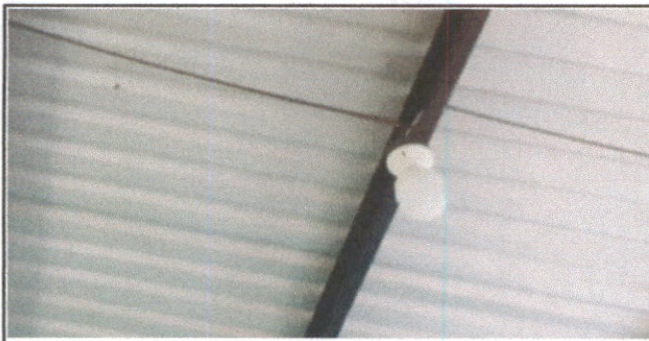
Foto 5: INSTALACION SISTEMA ELECTRICO PRINCIPAL
