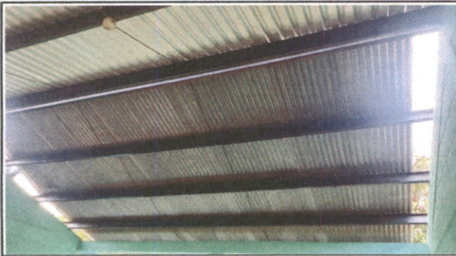
Foto1: MANTENIMIENTO A LA ESTRUCTURA DE METAL
