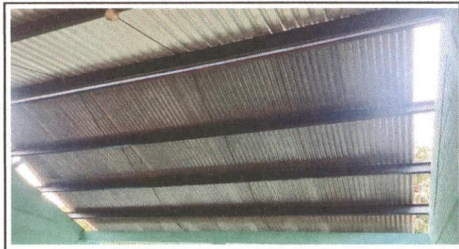
Foto 4: INSTALACION DE LAMINA POR LAMINA GALVANIZADA ALUZINC
