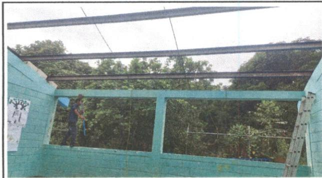
Foto1: SUSTITUCION DE LAMINA POR LAMINA GALVANIZADAALUZINC
