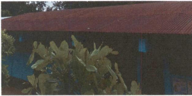
SUSTITUCIÓN DE LAMINA, POR LAMINA TROQUELADA ALIZINC CALIBRE 26
