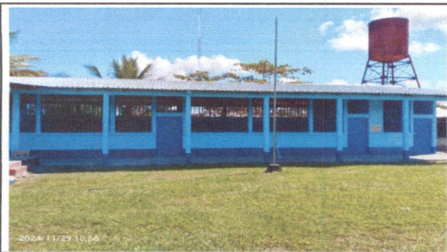
Foto 3: PINTURAS EN MUROS EXTERIORES
