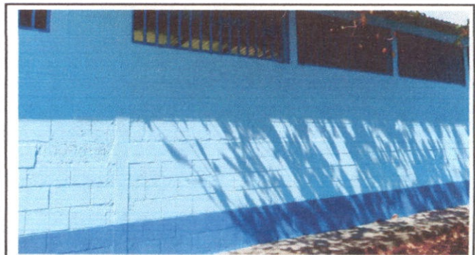
Foto 4: PINTURA EN MUROS INTERIORES
