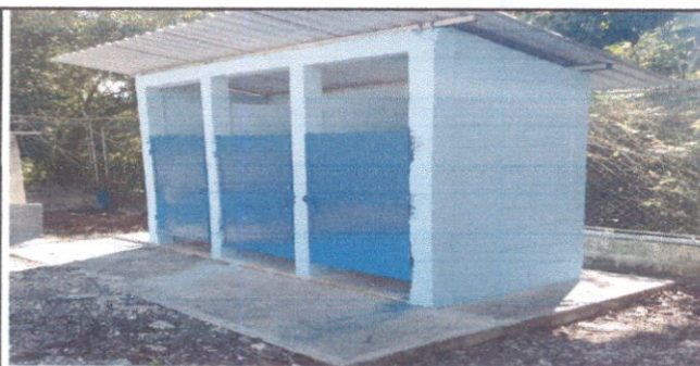
Foto 5: SUSTITUCION DE PUERTAS DE BAÑOS
