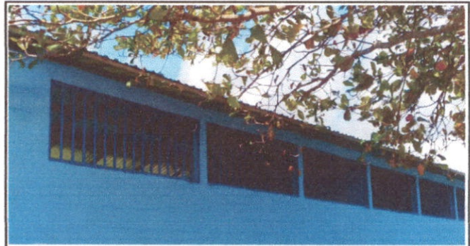
Foto 2: INSTALACION DE BALCONES
