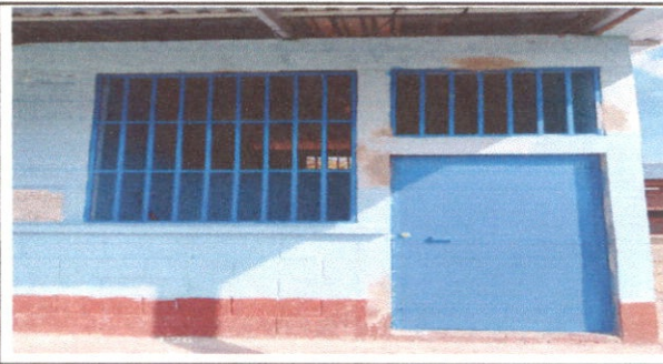
Foto 6: SUSTITUCION DE PUERTA DE AULAS
