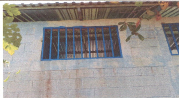
Foto 2: INSTALACION DE BALCONES
