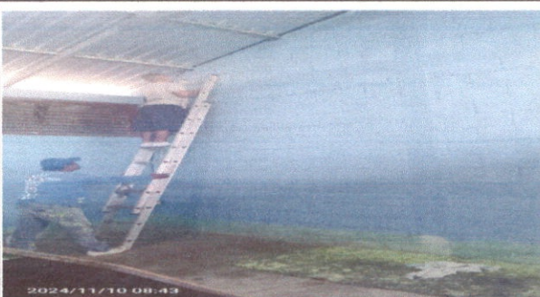
Foto 4: PINTURA EN MUROS INTERIORES
