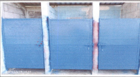
Foto 5: SUSTITUCION DE PUERTAS DE BAÑOS
