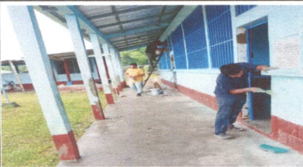
Foto 3: PINTURAS EN MUROS EXTERIORES
