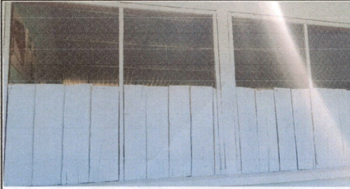
REPARACION Y MANTENIMIENTO DE VENTANAS Y BALCONES
