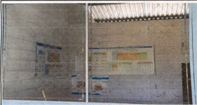
REPARACION DE VENTANA Y MALLA METALICA
