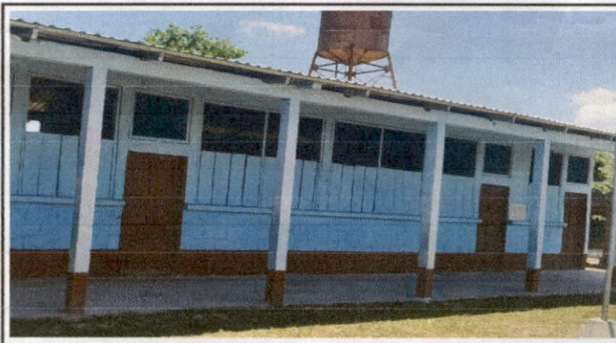
PINTURA EN MUROS INTERIORES Y EXTERIORES DE AULAS
