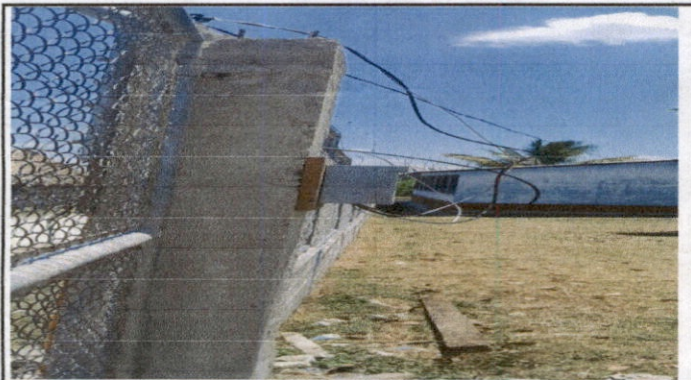
REPARACION Y MANTENIMIENTO DE SISTEMA ELECTRICO
