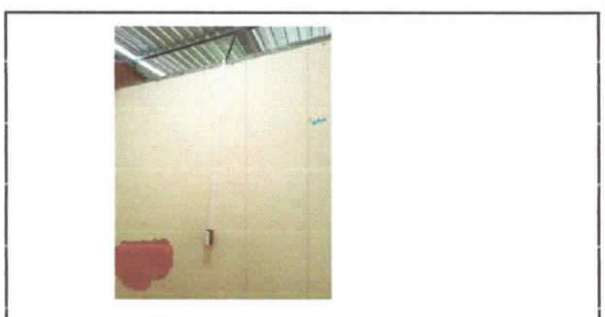
Foto 12: Sustrucción de tomacorrientes dobles
