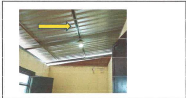
Foto 13: Reparación de cableado eléctrico
