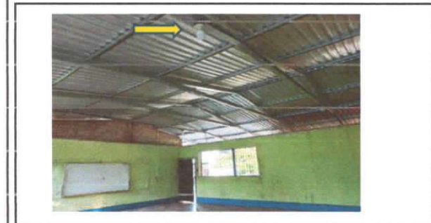
Foto 9: Sustrucción de plafoneras
