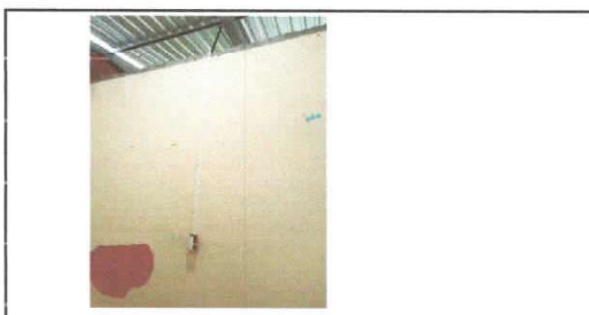
Foto 12: Sustrucción de tomacorrientes dobles
