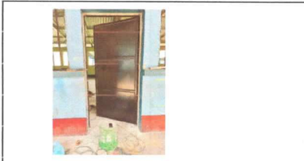
Foto 7: Sustrucción de chapa del Establecimiento
