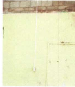
Foto 14: Sustitución de ducto eléctrico + accesorios
