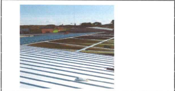
Foto 2: Sustitución de capote de lámina para lámina troquelada del Centro Educativo
