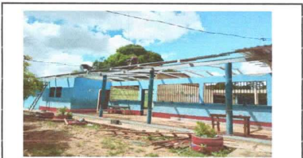
Foto 4: Sustitución de estructura de soporte de madera por metal del Centro Educativo
