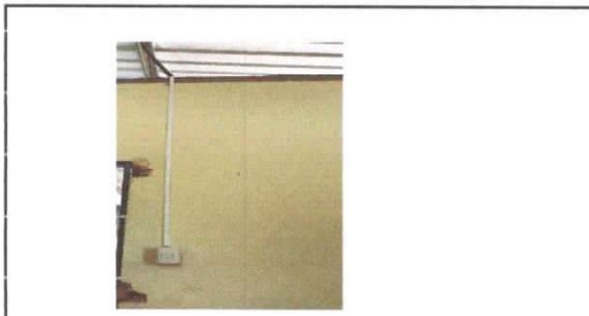
Foto 10: Sustrucción interruptores simples
