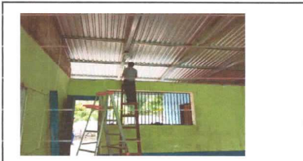
Foto 9: Sustrucción de plafoneras
