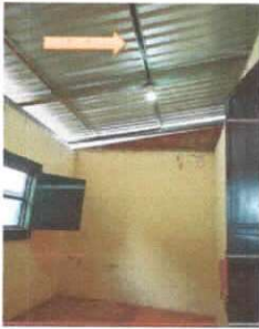
Foto 13: Reparación de cableado eléctrico
