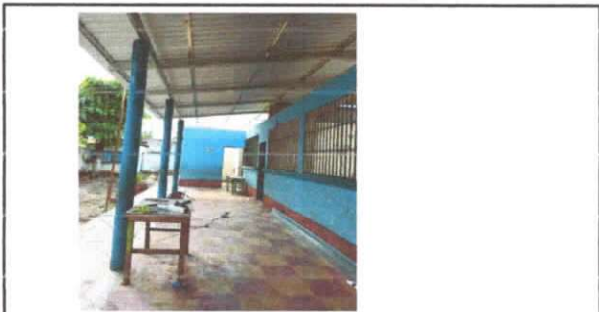
Foto 3: Sustitución de elementos de fijación del Centro Educativo
