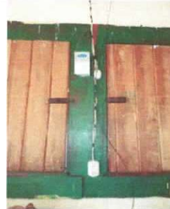
Foto 14: Sustitución de ducto eléctrico + accesorios
