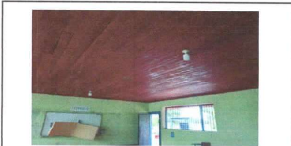
Foto 9: Sustrucción de plafoneras
