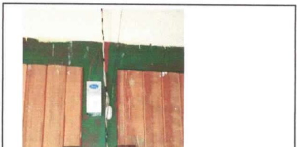
Foto 10: Sustrucción interruptores simples
