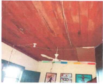
Foto 13: Reparación de cableado eléctrico
