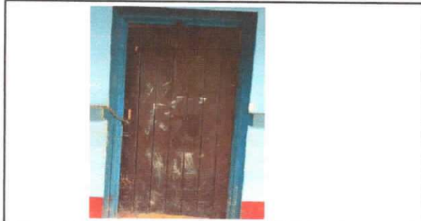
Foto 7: Sustrucción de chapa del Establecimiento
