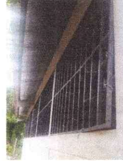
Foto 2: Sustitución de balcones de metal
