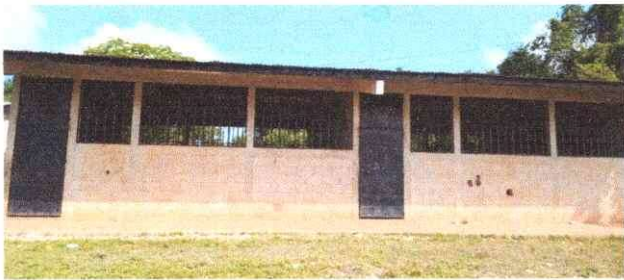
Foto 3: Pintura en muros exteriores e interiores.
