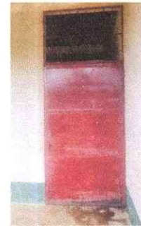
Foto 4: Mantenimiento a estructura (lijado, cambio de tubo, cepillado, sujeciones, aplicación de pintura)
