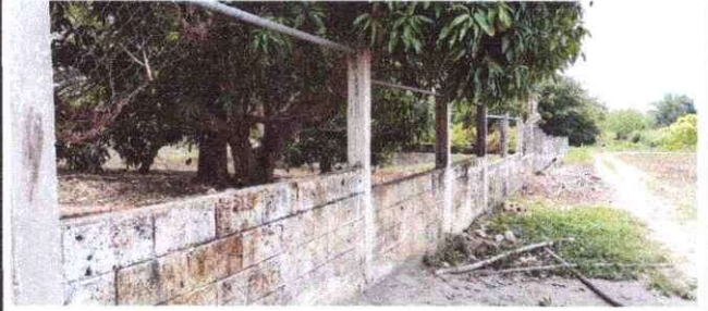
Foto 2: Reparación de tubo hg y malla galvanizada. ✓
