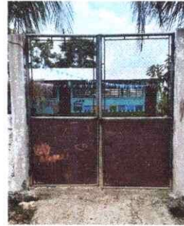
Foto 4: Sustrucción de portón de metal ✓
