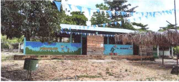
Foto 1: Sustrucción de lámina, por lámina troquelada aluzinc calibre 26 ✓
