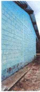
Foto 3: Pintura en muros exteriores e interiores. ✓
