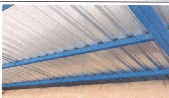
Foto 2: Cubierta de Lámina
