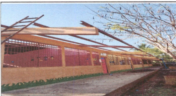
Foto 3: Estructura y Mantenimiento de Techo
