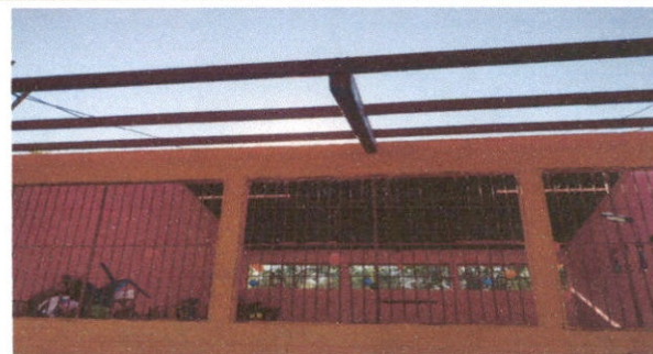
Foto 2: cubierta de lámina
