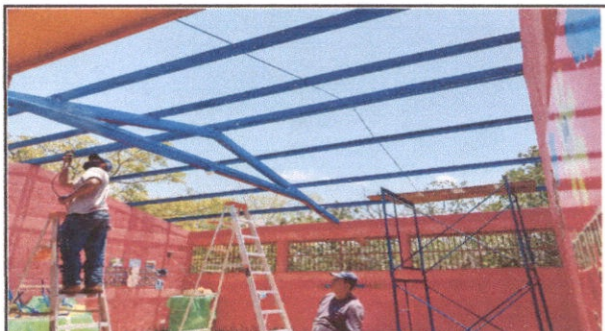
Foto 4: Estructura y mantenimiento de Techo
