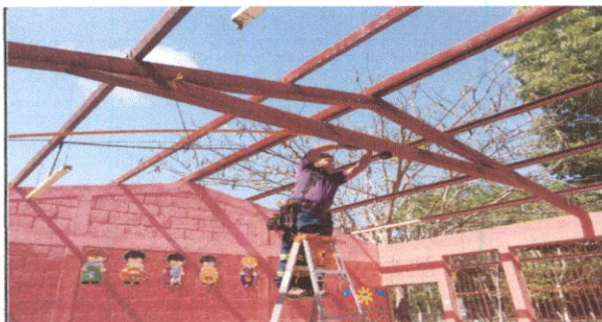
Foto 5: Reparación del Sistema Eléctrico
