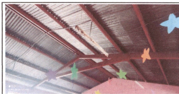
Foto 6: Reparacion del Sistema Electrico
