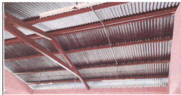
Foto 5: Reparacion del Sistema Electrico
