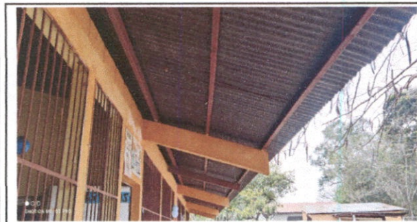
Foto 3: Estructura y Mantenimiento de techo
