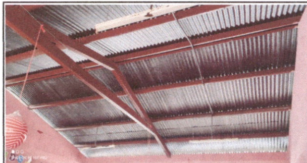
Foto 4: Estructura y mantenimiento del techo
