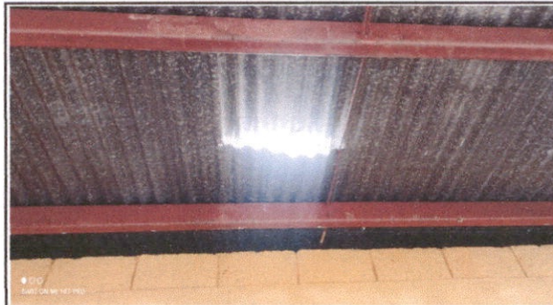
Foto 2: Reparacion cubierta de lámina
