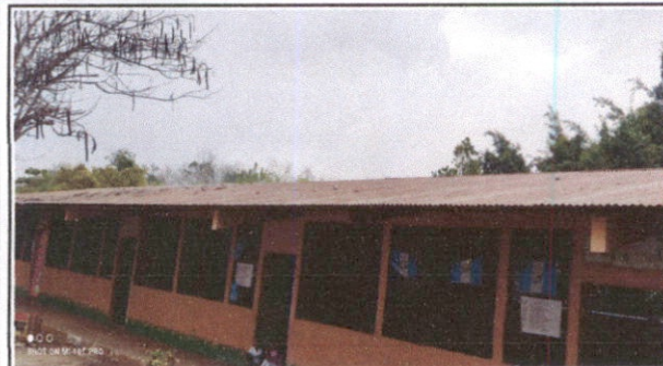
Foto1: Cubierta de Lámina
