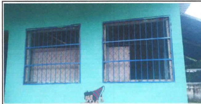
Foto 5: SUSTITUCIÓN DE BALCONES DE METAL
