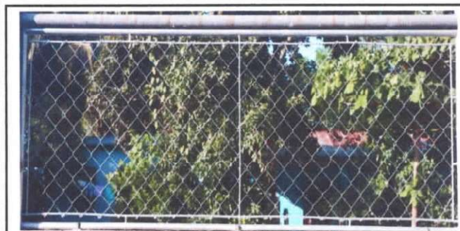
Foto 11: REPARACIÓN DE TUBO HG Y MALLA GALVANIZADA
