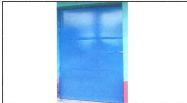
Foto 4: SUSTITUCIÓN DE PUERTA
