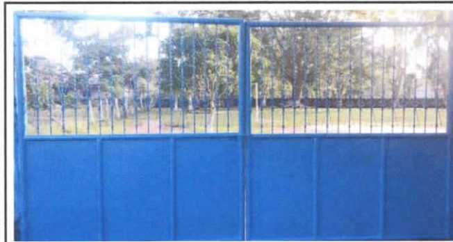
Foto 9: MANTENIMIENTO A PORTONES DE METAL
