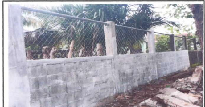
Foto 10: REPARACIÓN DE MURO PERIMETRAL DE BLOCK
