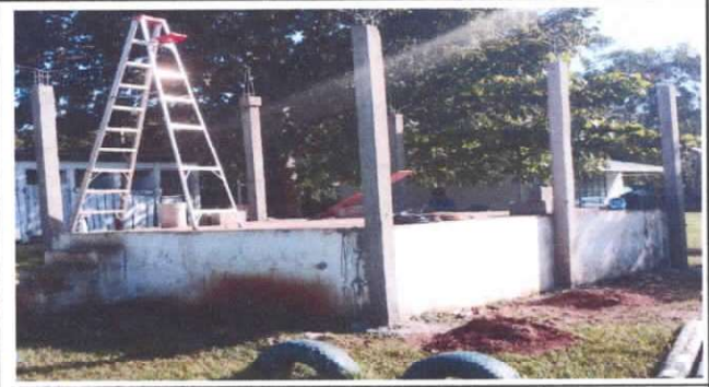
Foto 8: REPARACIÓN DE MURO DE CONTENCIÓN
