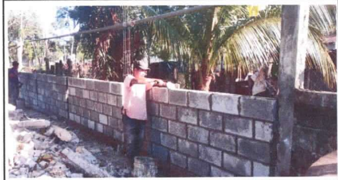
Foto 10: REPARACIÓN DE MURO PERIMETRAL DE BLOCK
