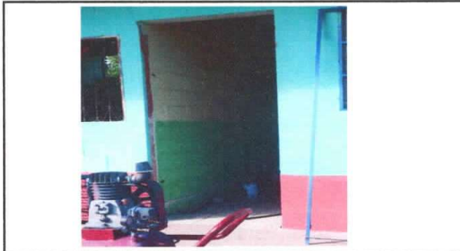
Foto 4: SUSTITUCIÓN DE PUERTA
