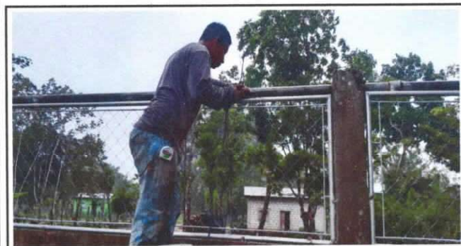
Foto 11: REPARACIÓN DE TUBO HG Y MALLA GALVANIZADA
