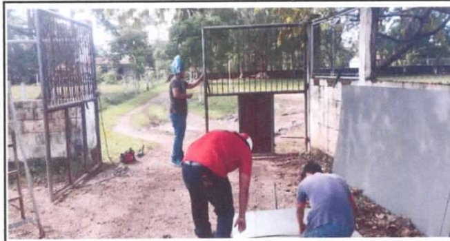
Foto 9: MANTENIMIENTO A PORTONES DE METAL
