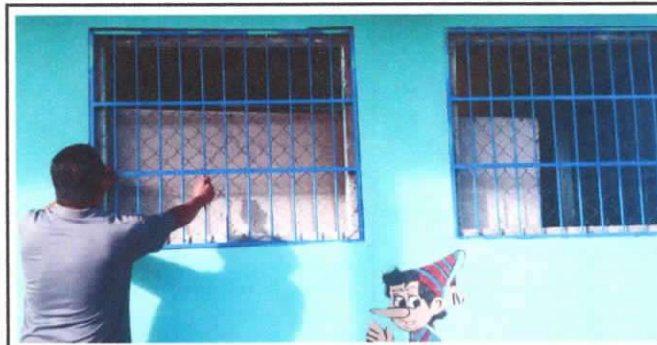
Foto 5: SUSTITUCIÓN DE BALCONES DE METAL
