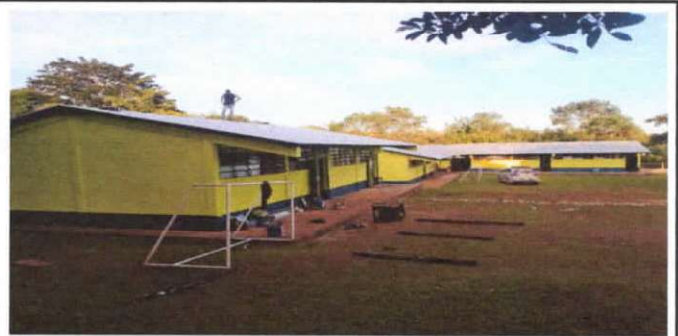
PINTURA EN MUROS EXTERIORES E INTERIORES
