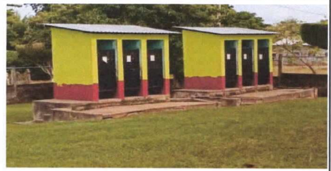
MANTENIMIENTO EN SERVICIOS SANITARIOS
