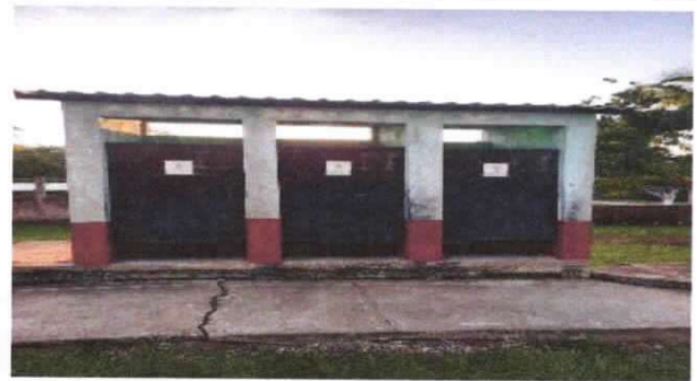
MANTENIMIENTO EN SERVICIOS SANITARIOS
