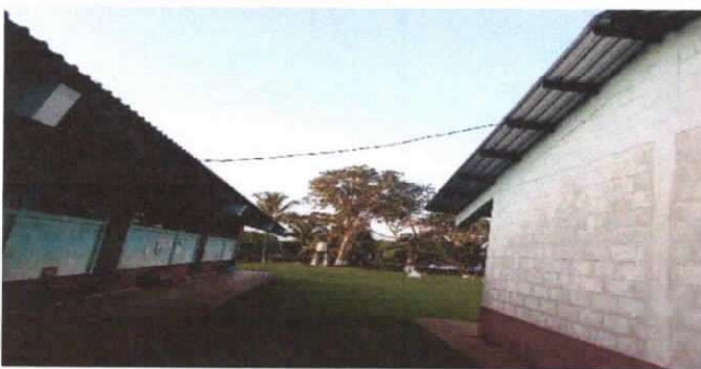
SUSTITUCIÓN DE DUCTO ELECTRICO MAS ACCASORIOS
