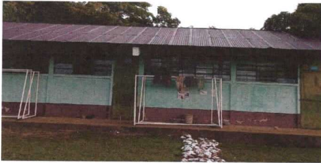
SUSTITUCIÓN DE LAMINA, POR LAMINA TROQUELADA ALUZINC CALIBRE 26
