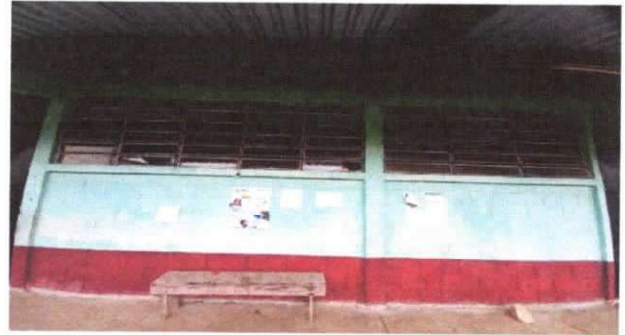
PINTURA EN MUROS EXTERIORES E INTERIORES
