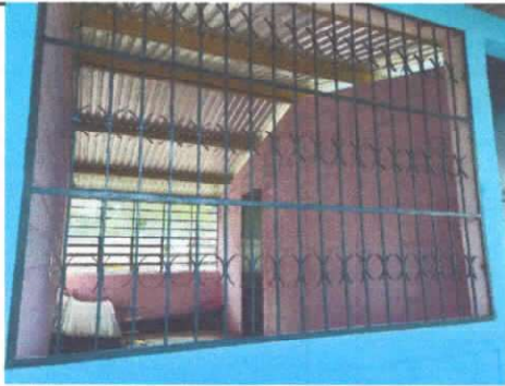
Foto 3: VENTANAS, Mantenimiento a balcones de metal,
