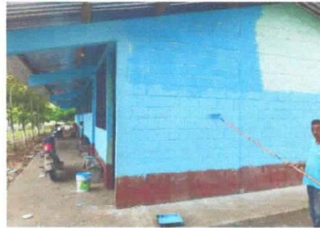
**Foto 4: PINTURA EN MUROS EXTERIORES E INTERIORES, Pintura en muros exteriores e interiores**
