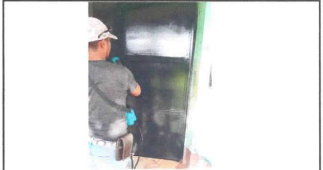
**Foto 2: PUERTAS DE METAL, Mantenimiento a estructura (lijado, cambio de tubo , cepillado, sujeciones, aplicación de pintura)**
