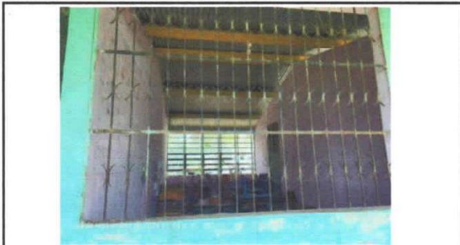
Foto 3: VENTANAS, Mantenimiento a balcones de metal,
