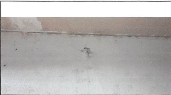
Foto 9: Sustitución de focos ahorradores
