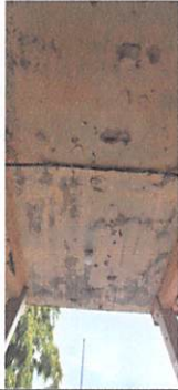
Foto 1: Impermeabilización de Losa
