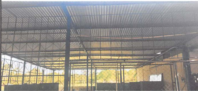
Foto 3: Sustitución de techo
