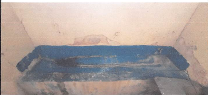
Foto 5: Sustitución de mingitorios
