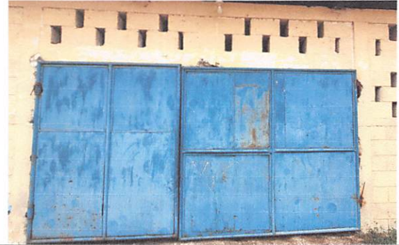
Foto 2: Sustitución de Portón
