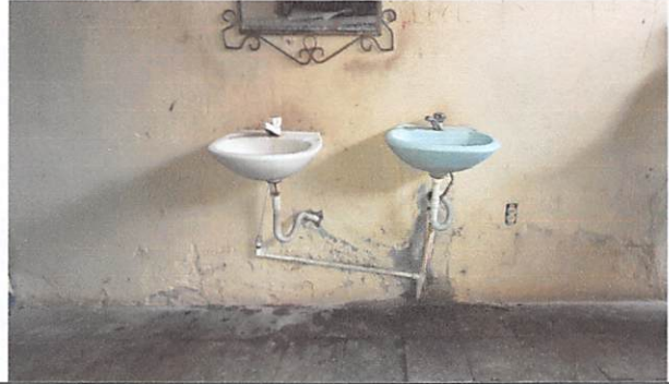
Foto 8: Sustitución de lavamanos
