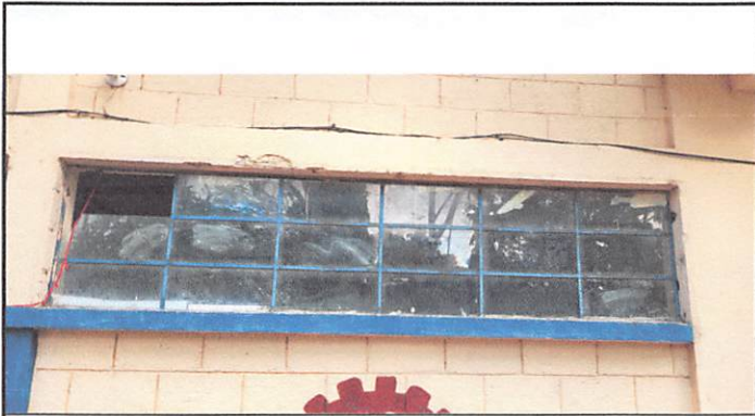
Foto 7: Sustitución de estructura de metal de ventana
