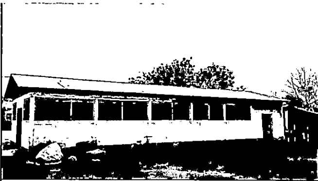
Foto 3: Cambio de estructura y lámina a un salón.
