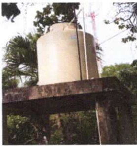
Foto 9: Sustitución de depósito de agua de 1000 lt.
