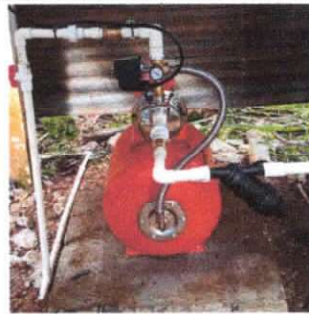
Foto 10: Sustitución bomba de agua
