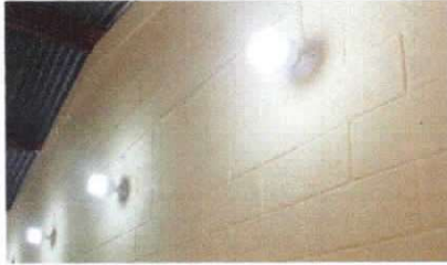
Foto 7: Reparación de Sistema Eléctrico
