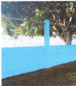
Foto 11: Reparación de muro perimetral de block
