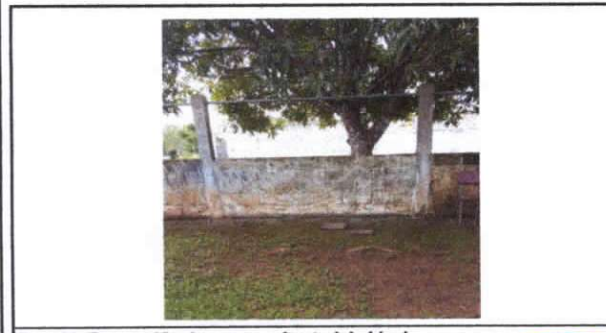
Foto 11. Reparación de muro perimetral de block
