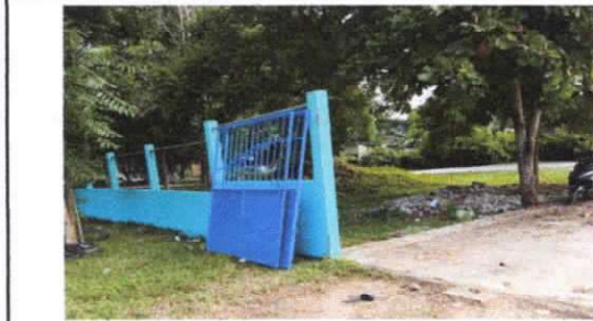
Foto 5: Mantenimiento de Porton
