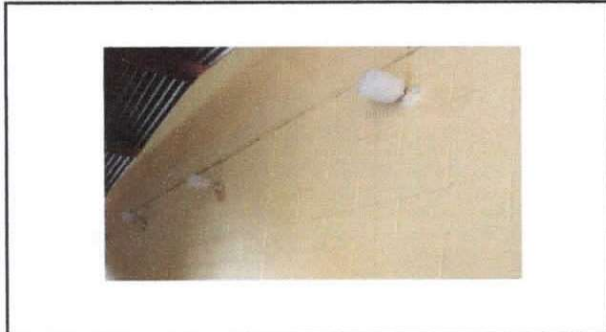
Foto 7: Reparación de Sistema Eléctrico
