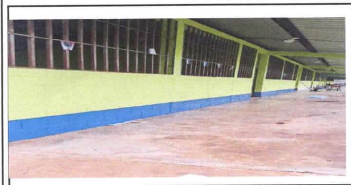
PINTURA EN MURO EXTERIOR E INTERIOR
