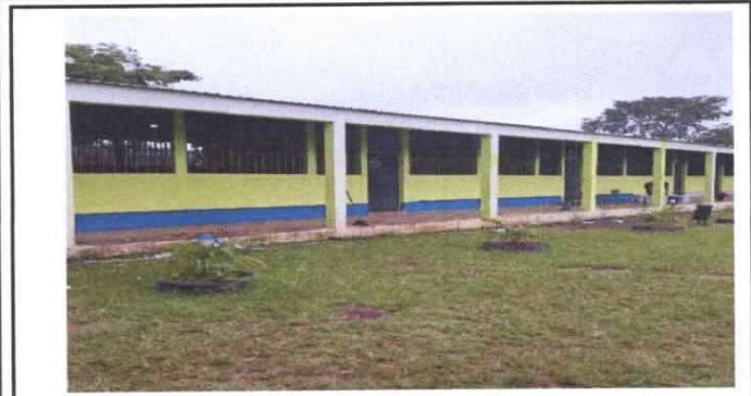
MANTENIMIENTO A ESTRUCTURA
