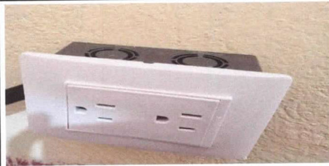
SUSTITUCIÓN DE TOMACORRIENTES DOBLES
