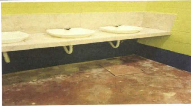
SUSTITUCIÓN DE LAVAMANOS
