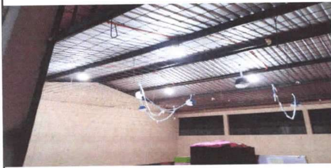
SUSTITUCIÓN DE FOCOS AHORRADORES
