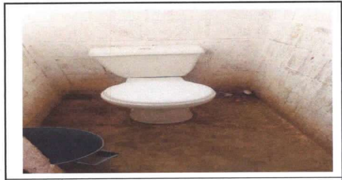
SUSTITUCIÓN DE INODORO
