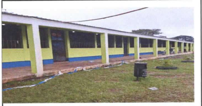
MANTENIMIENTO EN BALCON DE METAL EN VENTANA
