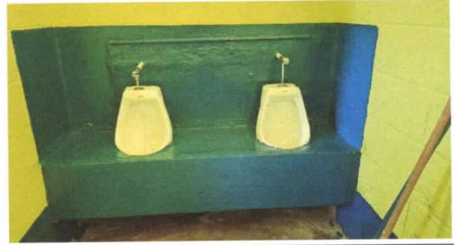
SUSTITUCIÓN DE MIGITORIOS
