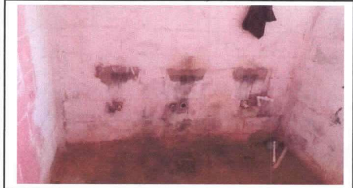
SUSTITUCIÓN DE LAVAMANOS
