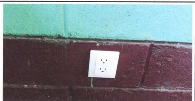
SUSTITUCIÓN DE TOMACORRIENTES DOBLES
