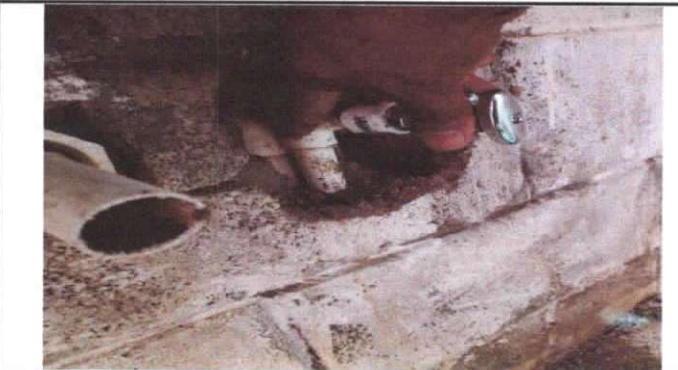
SUSTITUCIÓN DE MIGITORIOS
