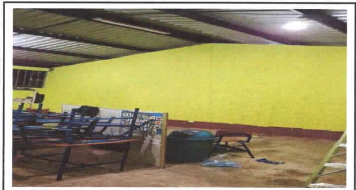
SUSTITUCIÓN DE FOCOS AHORRADORES
