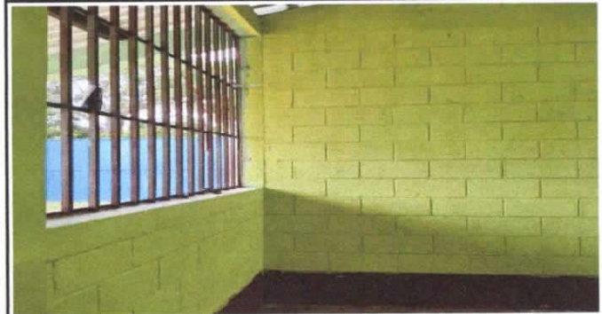
MANTENIMIENTO EN BALCON DE METAL EN VENTANA
