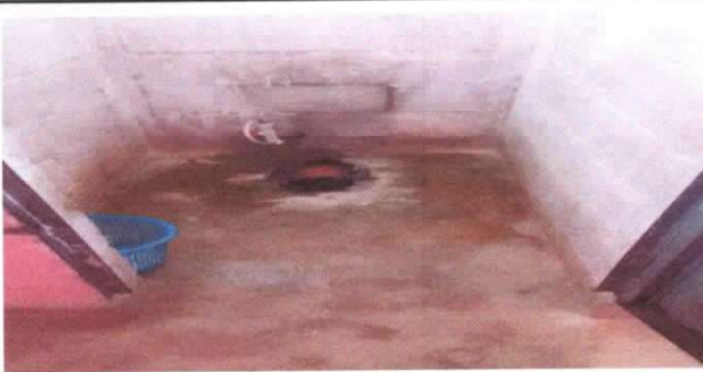
SUSTITUCIÓN DE PUERTA EN SERVICIO SANITARIO
