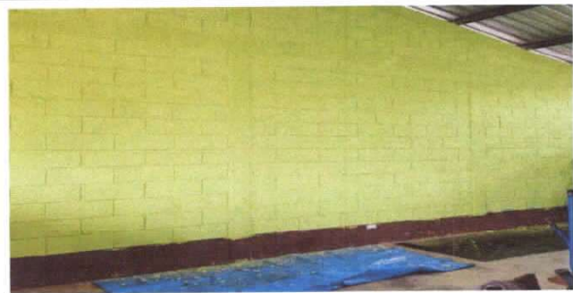
PINTURA EN MURO EXTERIOR E INTERIOR
