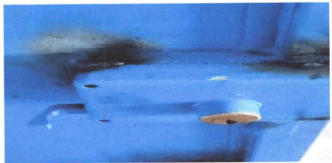
SUSTITUCIÓN DE CHAPAS
