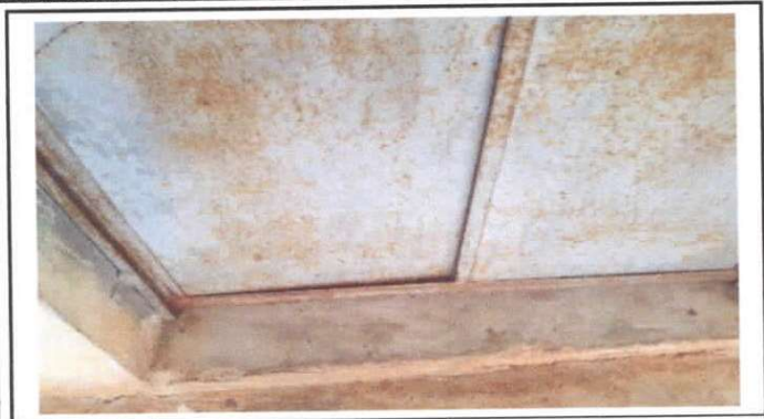
MANTENIMIENTO A ESTRUCTURA
