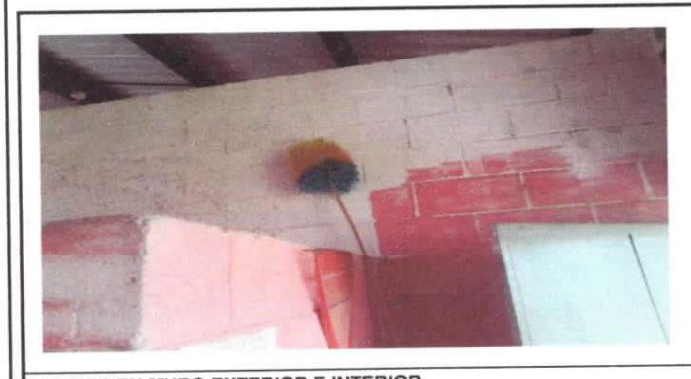
PINTURA EN MURO EXTERIOR E INTERIOR
