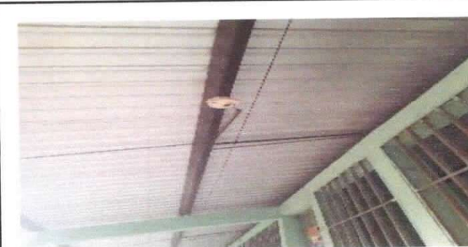
SUSTITUCIÓN DE PLAFONERAS
