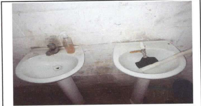
SUSTITUCIÓN DE LAVAMANOS
