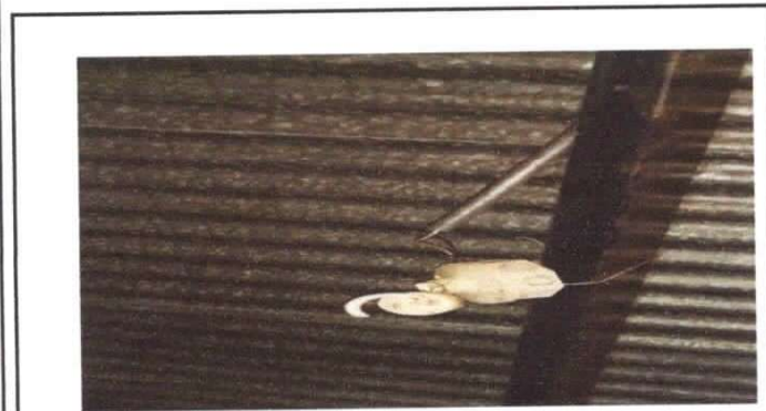
SUSTITUCIÓN DE FOCOS AHORRADORES
