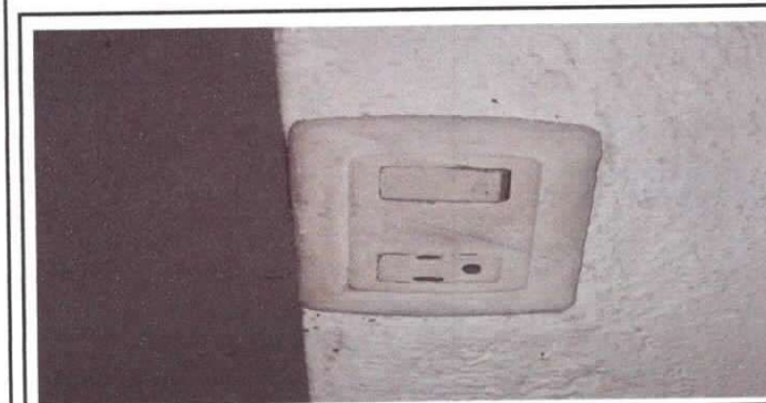
SUSTITUCIÓN DE INTERRUPTORES DOBLES
