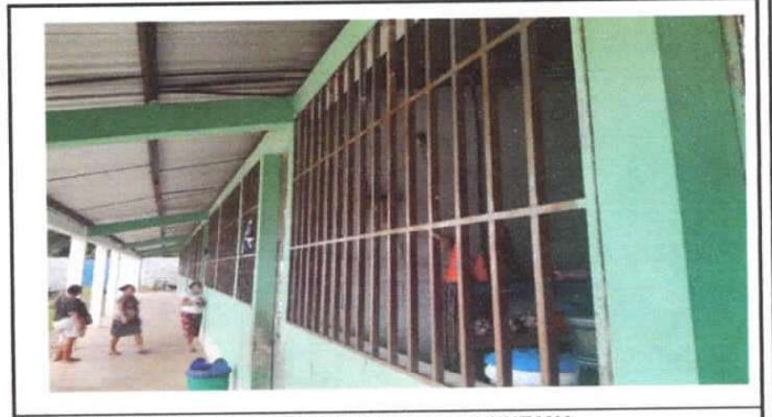
MANTENIMIENTO EN BALCON DE METAL EN VENTANA
