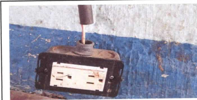
SUSTITUCIÓN DE TOMACORRIENTES DOBLES
