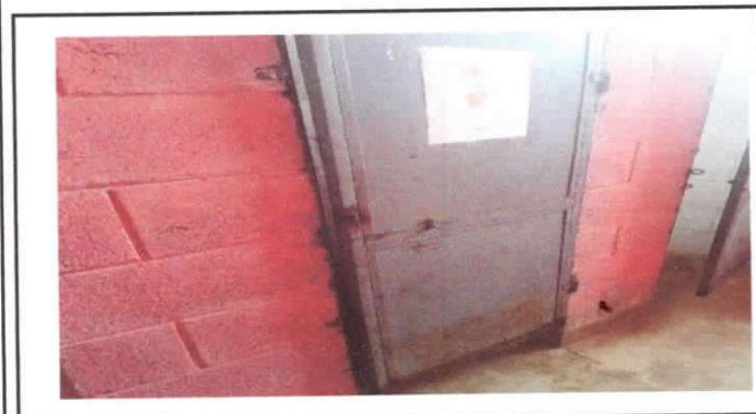
SUSTITUCIÓN DE PUERTA EN SERVICIO SANITARIO
