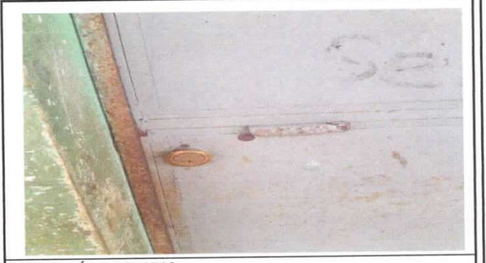
SUSTITUCIÓN DE CHAPAS
