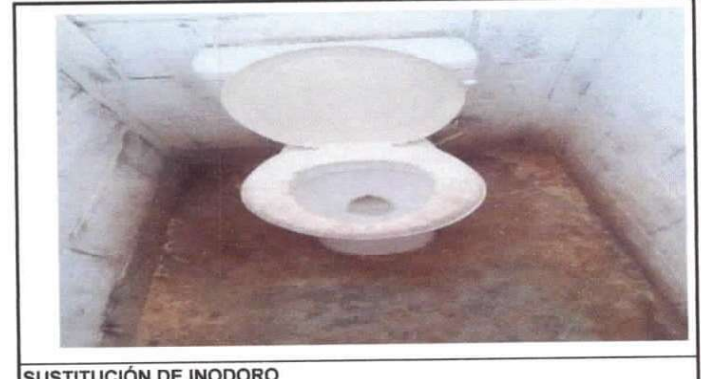
SUSTITUCIÓN DE INODORO
