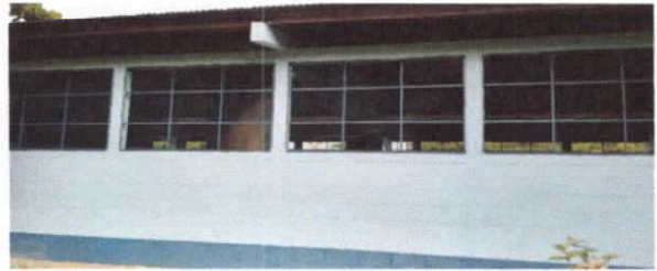
Foto 10: Mantenimiento a balcones de metal
