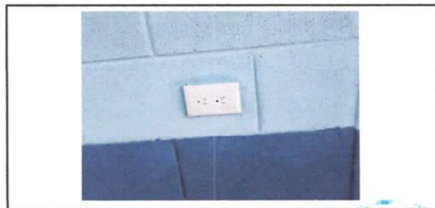
Foto 6: Reparación de cableado eléctrico
