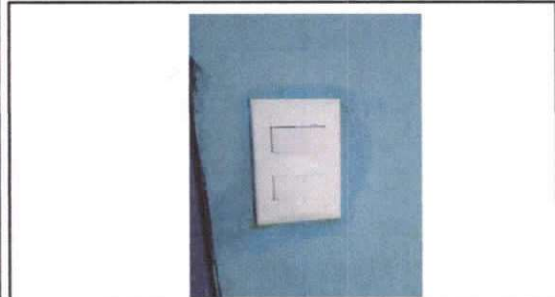
Foto 3: Sustritiución interruptores dobles
