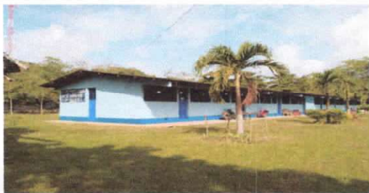
Foto 11: Pintura en muros exteriores e interiores
