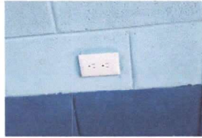
Foto 12: Sustrucción de tomacorrientes dobles
