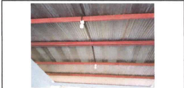
Foto 2: Sustritiución de plafoneras
