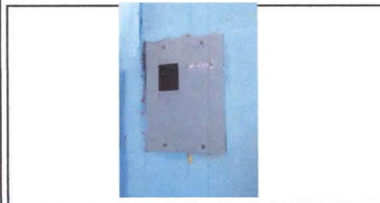
Foto 5: Sustritiución de tablero de flipones
