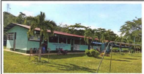
Foto 11: Pintura en muros exteriores e interiores
