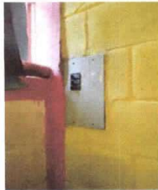
Foto 5: Sustrucción de tablero de flípones
