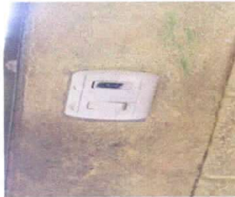
Foto 3: Sustrucción interruptores dobles
