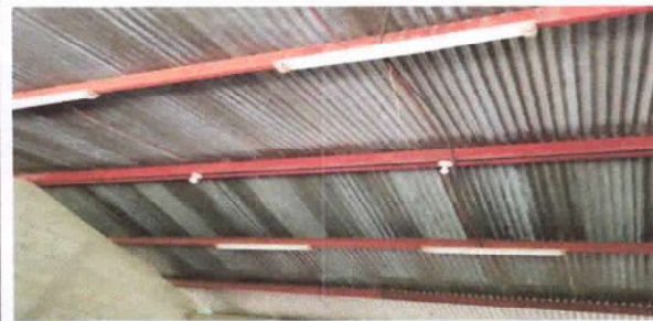
Foto 2: Sustrucción de plafoneras
