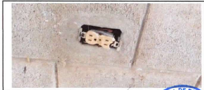
Foto 12: Sustrucción de tomacorrientes dobles
