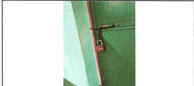
Foto 8: Sustrucción de chapa
