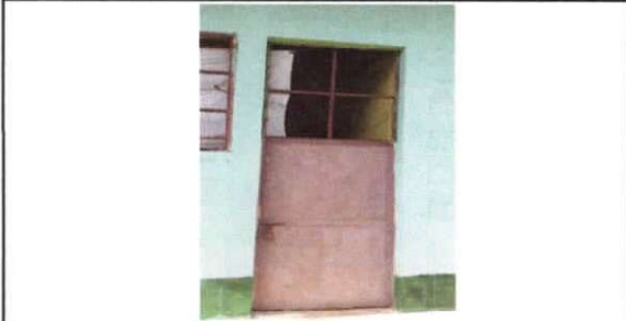
Foto 7: Sustrucción de puerta
