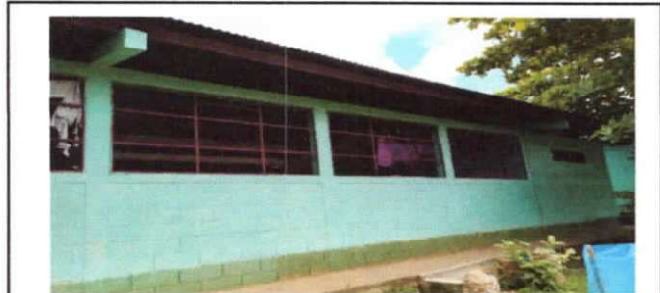
Foto 10: Mantenimiento a balcones de metal
