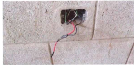
Foto 6: Reparación de cableado eléctrico
