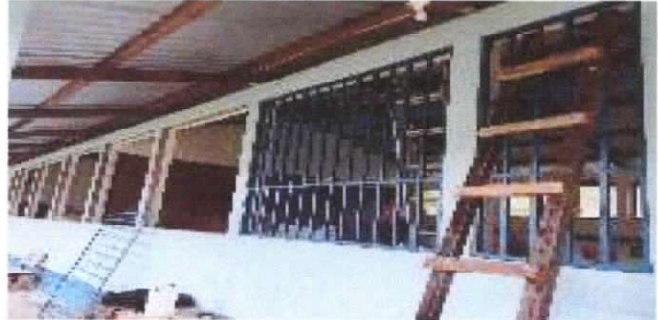
SUSTITUCIÓN DE BALCON DE METAL POR METAL
