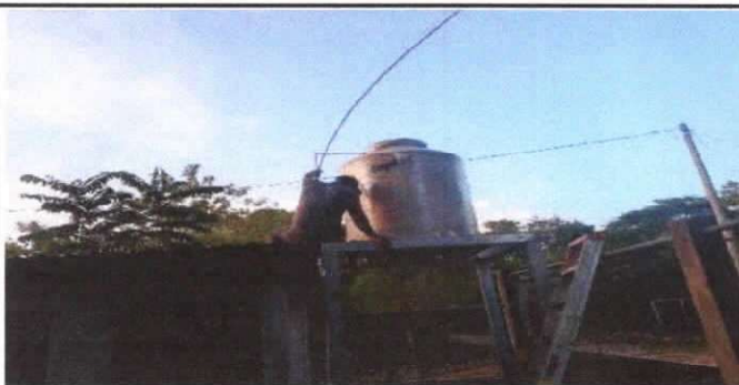
SUSTITUCIÓN DE DEPOSITO DE AGUA 1,100 LITROS
