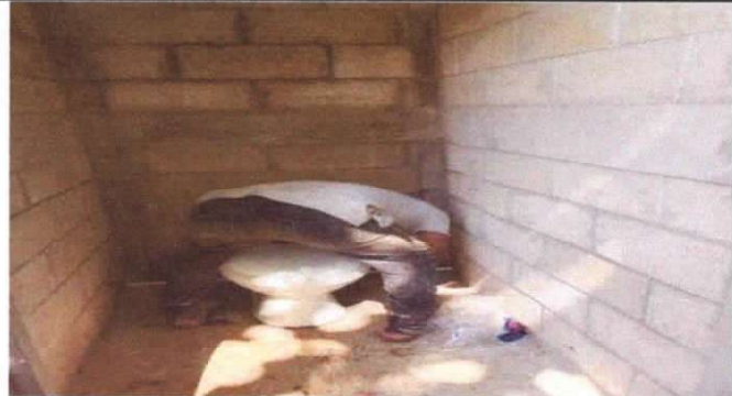
SUSTITUCIÓN DE INODORO
