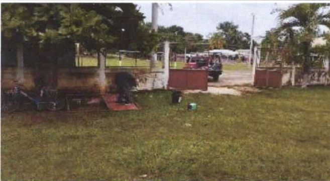
MANTENIMIENTO A PORTON DE METAL
