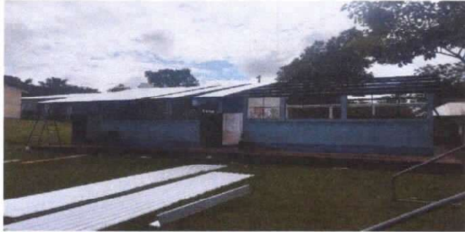
SUSTITUCIÓN DE LAMINA, POR LAMINA TROQUELADA ALUZINC CALIBRE 26
