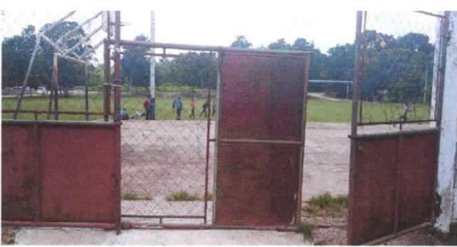
MANTENIMIENTO A PORTON DE METAL
