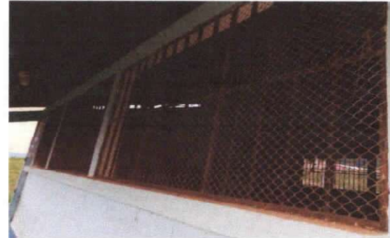
SUSTITUCIÓN DE BALCON DE METAL POR METAL
