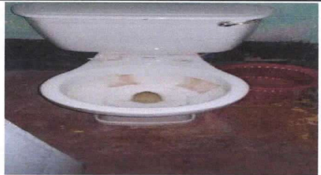
SUSTITUCIÓN DE INODORO
