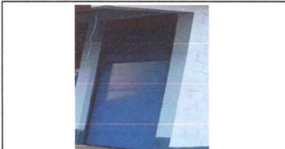
Foto 4: Mantenimiento a estructura (lijado, cambio de tubo , cepillado, sujeciones, aplicación de pintura) Puertas de aulas
