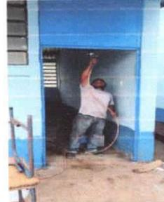
Foto 4: Mantenimiento a estructura (lijado, cambio de tubo , cepillado, sujetiones, aplicación de pintura) Puertas de aulas
