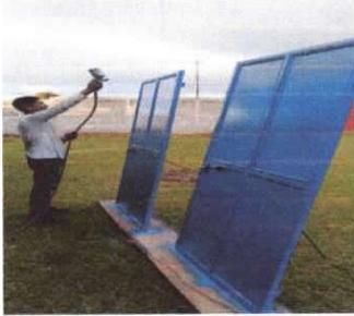
Foto 7: Mantenimiento a estructura (lijado, cambio de tubo , cepillado, sujeciones, aplicación de pintura) a puertas servicios sanitarios
