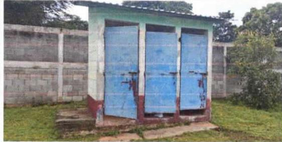
Foto 7: Mantenimiento a estructura (lijado, cambio de tubo , cepillado, sujeciones, aplicación de pintura) a puertas servicios sanitarios
