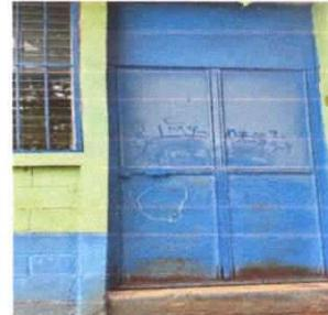
Foto 4: Mantenimiento a estructura (lijado, cambio de tubo , cepillado, sujeciones, aplicación de pintura) Puertas de aulas
