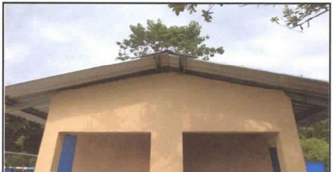
SUSTITUCION DE CAPOTES DE LAMINA, PARA LAMINA TROQUELADA
