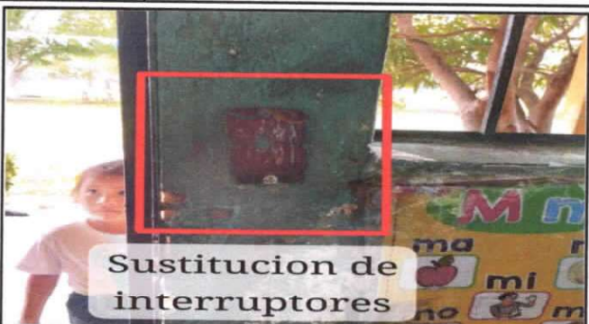
Sustitución interruptores dobles
