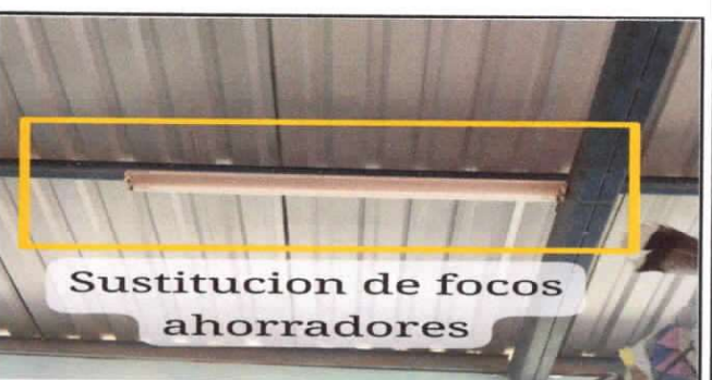
Sustitución de focos ahorradores
