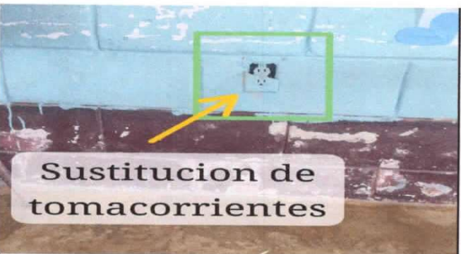
Sustitución de tomacorrientes dobles
