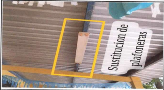
Sustitución de plafoneras
