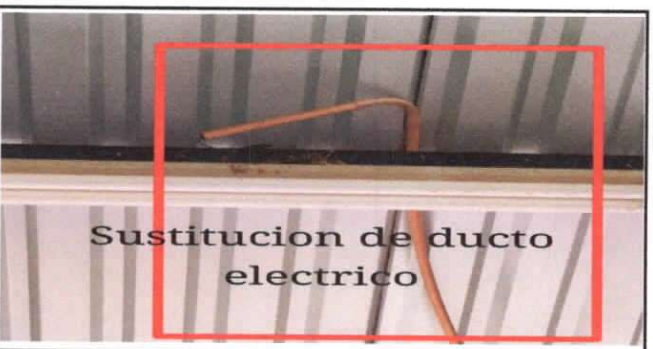
Sustitución de ducto eléctrico + accesorios
