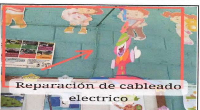
Reparación de cableado electrico
