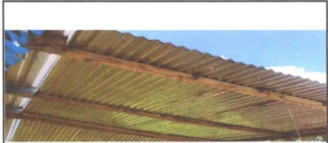
Sustitución de lámina, por lámina troquelada aluzinc calibre 26
