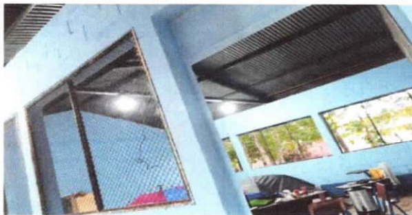
SUSTITUCIÓN DE PLAFONERAS
