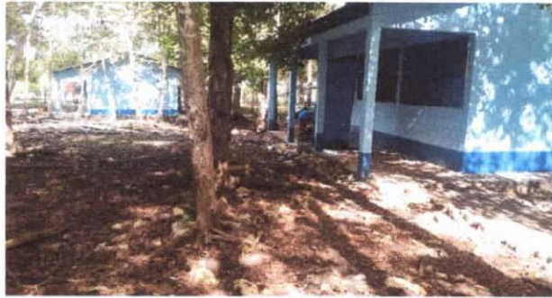
SUSTITUCIÓN DE LAMINA POR LAMINA TROQUELADA ALIZINC CALIBRE 26
