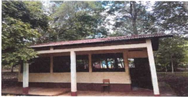
SUSTITUCIÓN DE LAMINA POR LAMINA TROQUELADA ALIZINC CALIBRE 26
