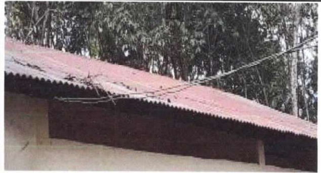
SUSTITUCIÓN DE CABLE PRINCIPAL
