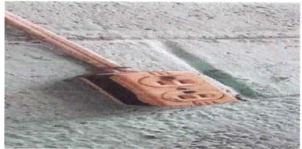
SUSTITUCIÓN DE TOMACORRIENTES DOBLES
