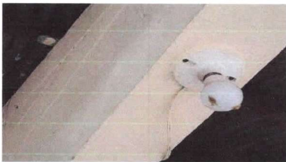
SUSTITUCIÓN DE PLAFONERAS
