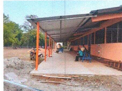
Foto 4: Aleta de instituto terminado y su orcones de concreto
