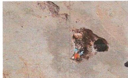
Foto 6: Se observa el piso dañada de las aulas para ser arrecaglado con piso de cerramica.
