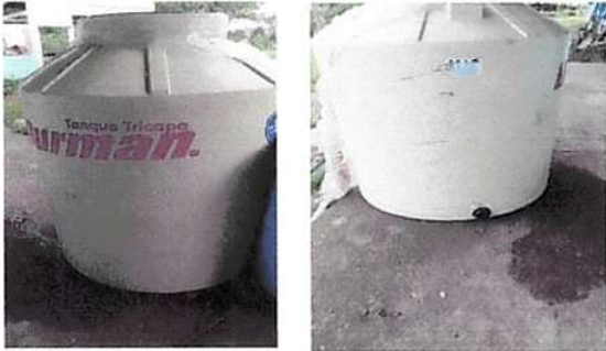
Foto 7: SUSTITUCION DE DEPOSITO DE AGUA 1100 LITROS
