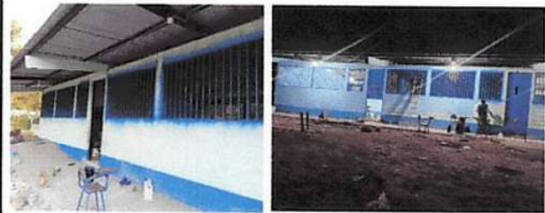
Foto 4: PINTURA EN MUROS, EXTERIORES E INTERIORES
