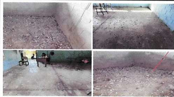
Foto 1: SUSTITUCION DE PISO DE CEMENTO LIQUIDO
