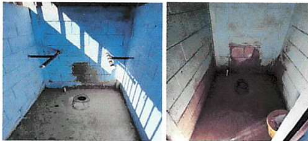
Foto 5: SUSTITUCION DE INODORO
