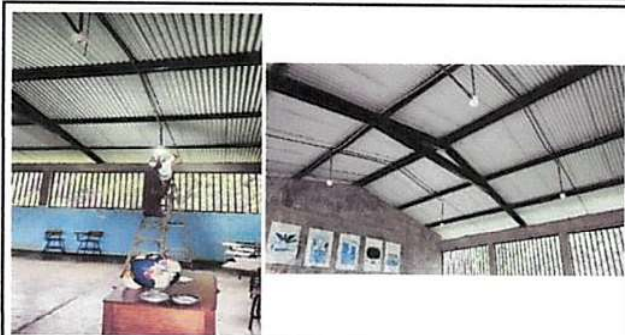
Foto 2: SUSTITUCION DE LAMPARA DE 2X40
