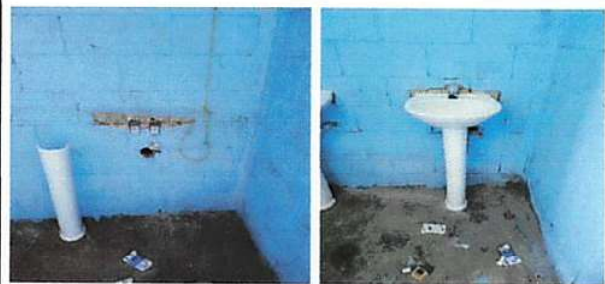
Foto 6: SUSTITUCION DE LAVAMANOS
