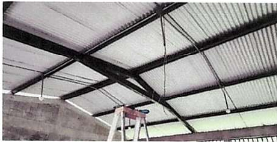
Foto 3: SUSTITUCION DE DUCTO ELECTRICO + ACCESORIOS
