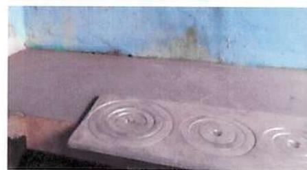
Foto 11: sustucion de plancha de metal de 3 homillas
