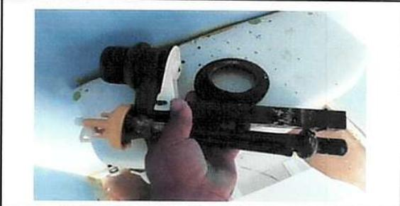
Foto 12: Sustitución de accesorios inodoro (contra llave, tubo de abasto y tanque)
