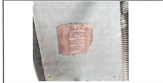
Foto 7: Sustrucción interruptores dobles
