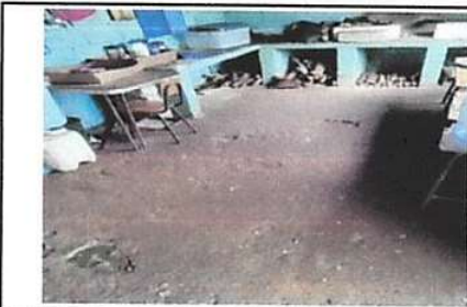
Foto 2: Sustitución de piso de torta de concreto
