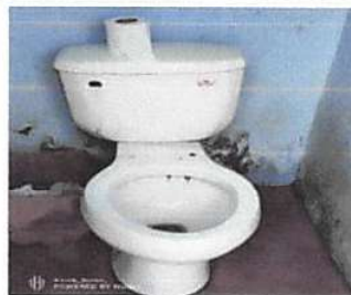
Foto 13: Sustitución tapadera sanitario
