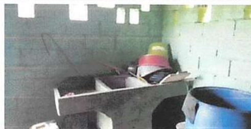
Foto 15: Sustitución de pila de cemento de dos lavaderos
