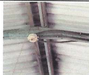
Foto 5: Sustitución de focos ahorradores
