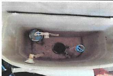
Foto 12: Sustitución de accesorios inodoro (contra llave, tubo de abasto y tanque)
