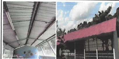
Foto1: Sustitución de lamina, por lamina troquelada aluzinc calibre 26
