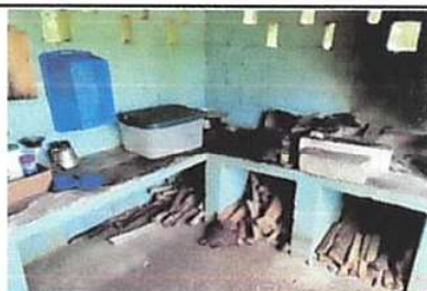
Foto 16: Instalación de azulejo en estufa rural
