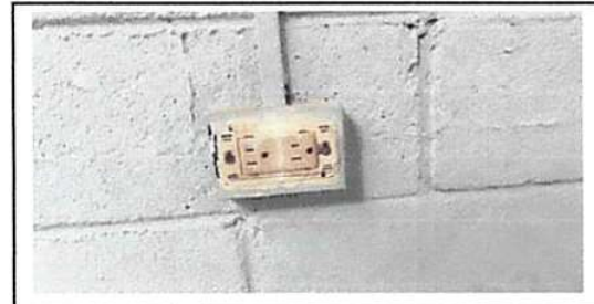
Foto 9: Sustrucción de tomacorrientes dobles
