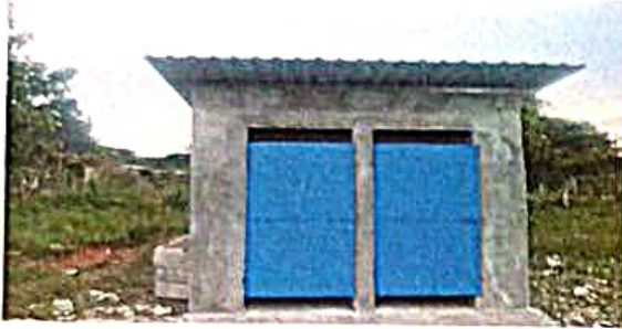
SUSTITUCIÓN DE INODORO
