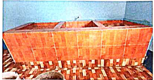
SUSTITUCIÓN DE PILA DE 2 LAVADEROS
