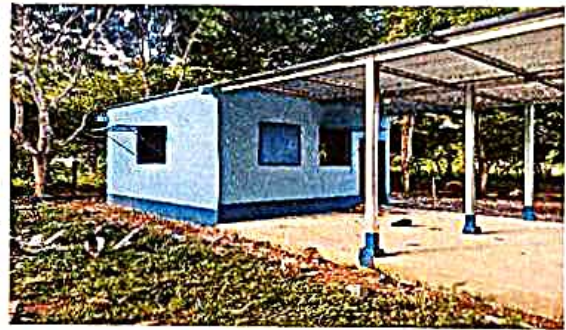
SUSTITUCIÓN DE SOPORTE DE MADERA POR METAL
