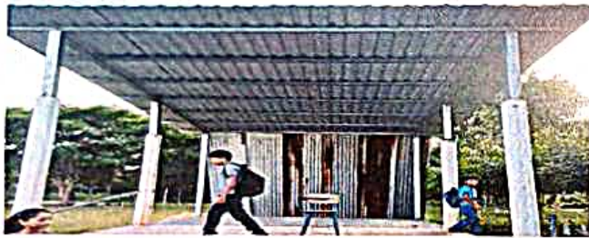
SUSTITUCIÓN DE LAMINA, POR LAMINA TROQUELADA ALUZING
