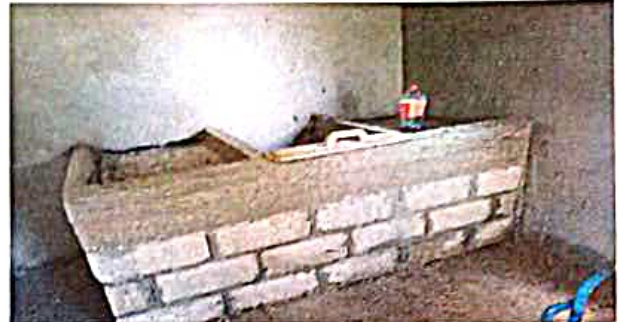
SUSTITUCIÓN DE PILA DE 2 LAVADEROS
