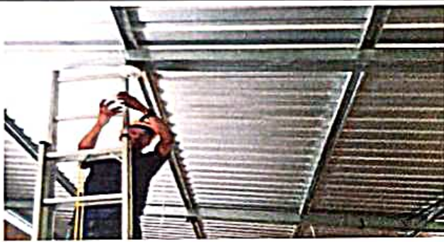
SUSTITUCIÓN DE LAMINA, POR LAMINA TROQUELADA ALUZING
