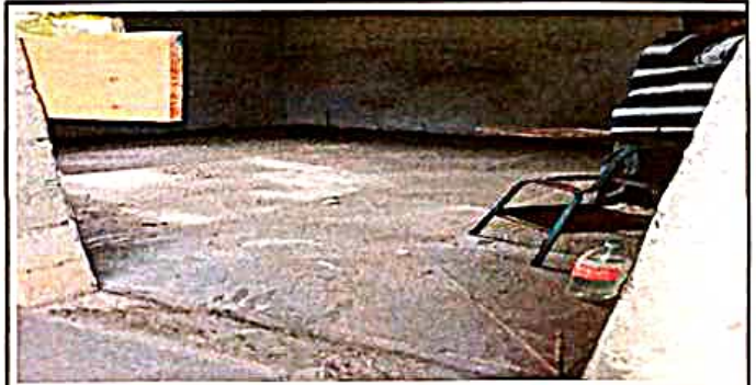
SUSTITUCIÓN DE TORTA DE CEMENTO
