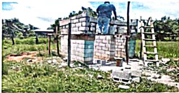
SUSTITUCIÓN DE INODORO
