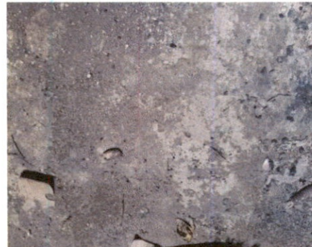
SUSTITUCIÓN DE TORTA DE CEMENTO
