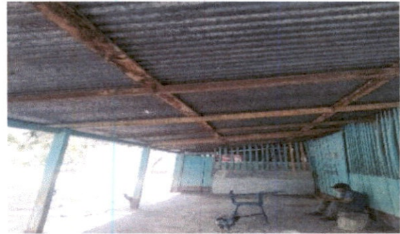
SUSTITUCIÓN DE SOPORTE DE MADERA POR METAL
