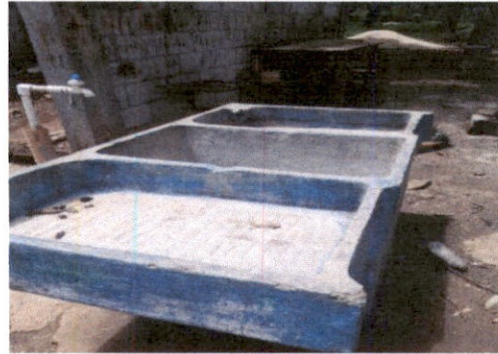
SUSTITUCIÓN DE PILA DE 2 LAVADEROS
