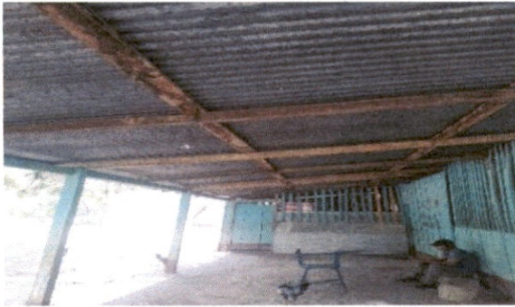
SUSTITUCIÓN DE LAMINA, POR LAMINA TROQUELADA ALUZINC CALIBRE 26
